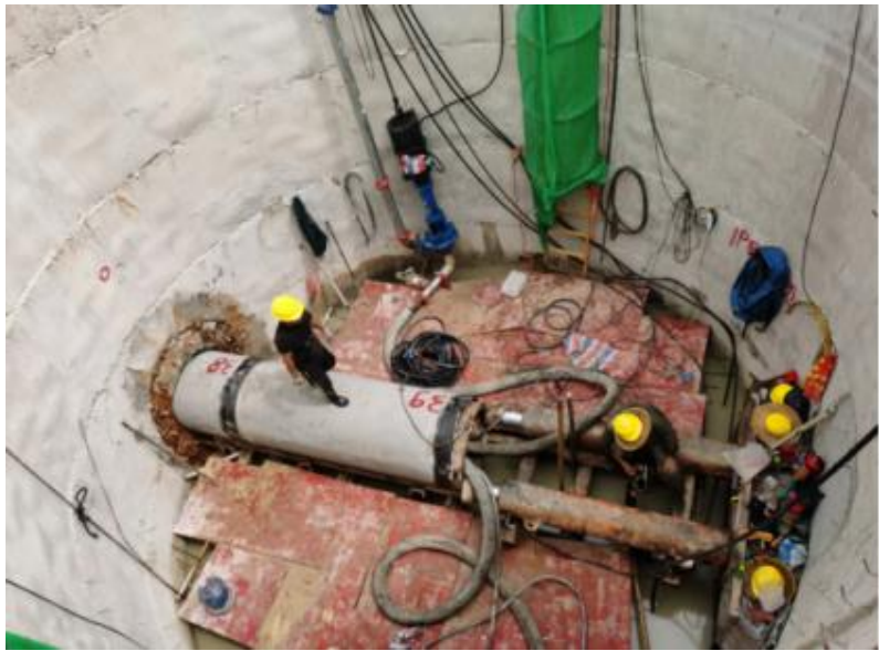
图 8-6 泥水平衡顶管施工现场
