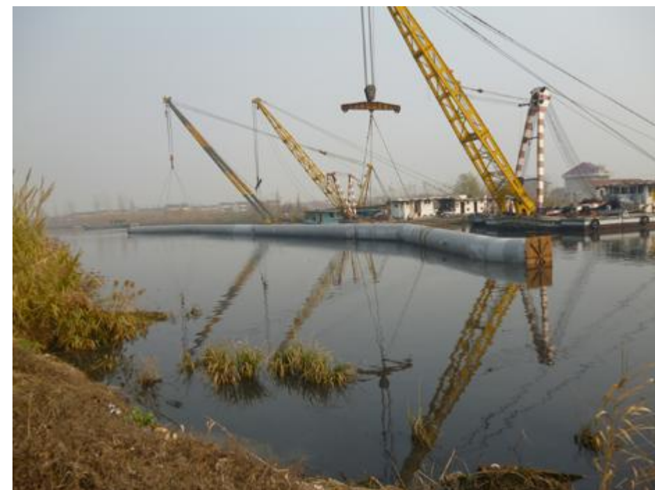
图 3-2 过河沉井施工
