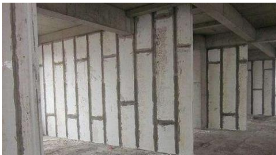
图7-12 内隔墙实物图
