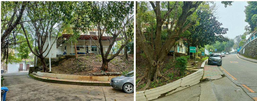
拟拆除发热门诊地段高差情况
