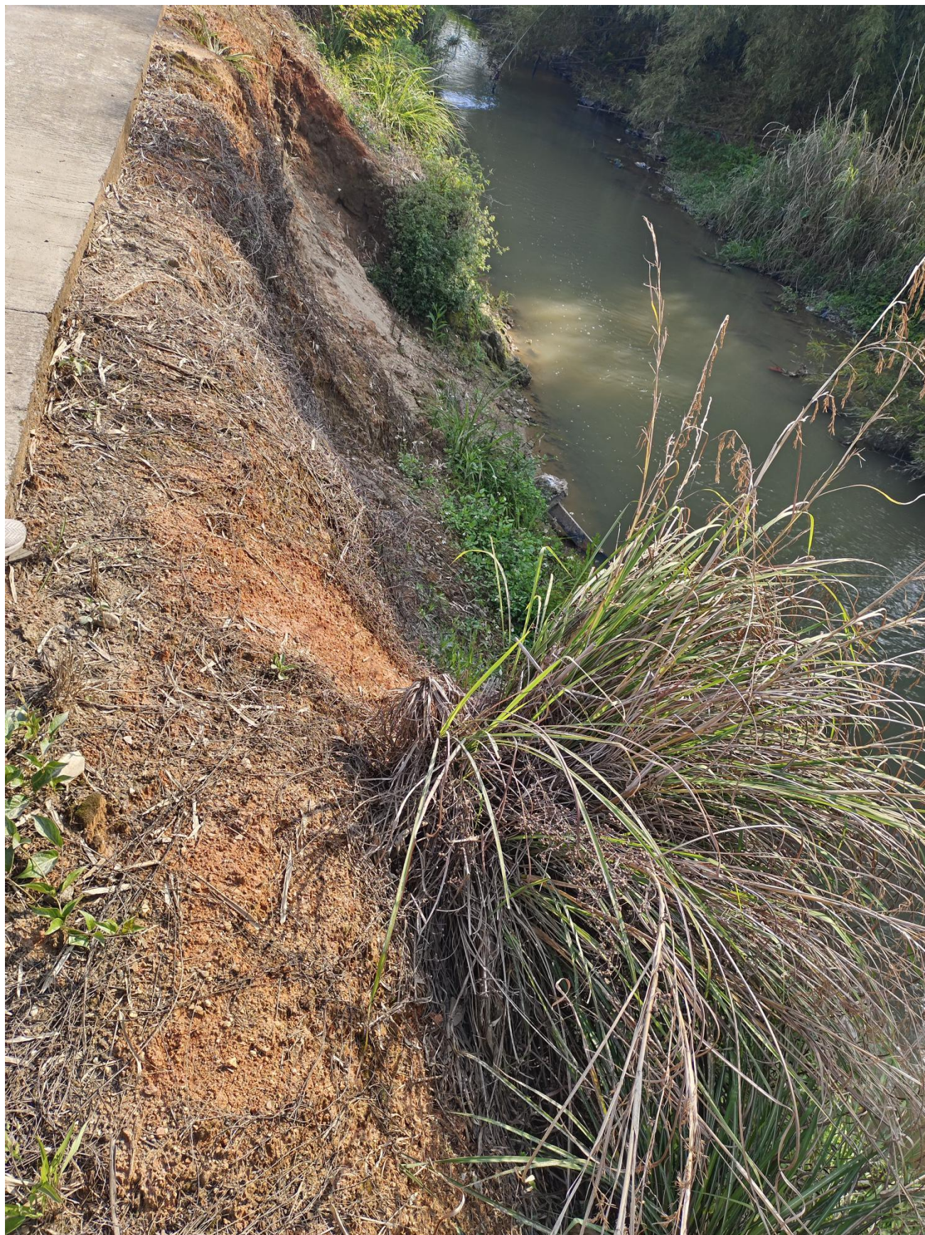
图 2.1-5 高宅水水毁河堤 2#现状照片
