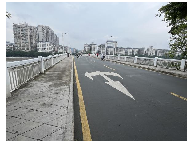
风采桥桥面照
