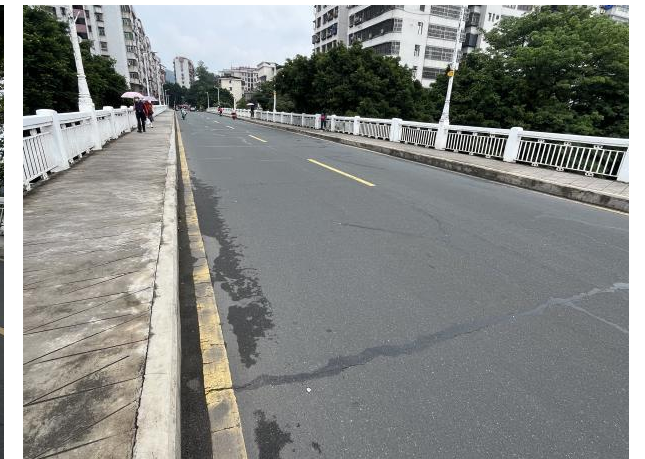
风采桥桥面照
