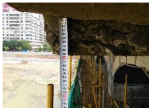
右侧59#悬臂梁小桩侧搭板平台存在整体下沉9cm
