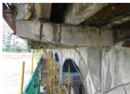
右侧59#悬臂梁小桩侧搭板平台存在整体下沉9cm
