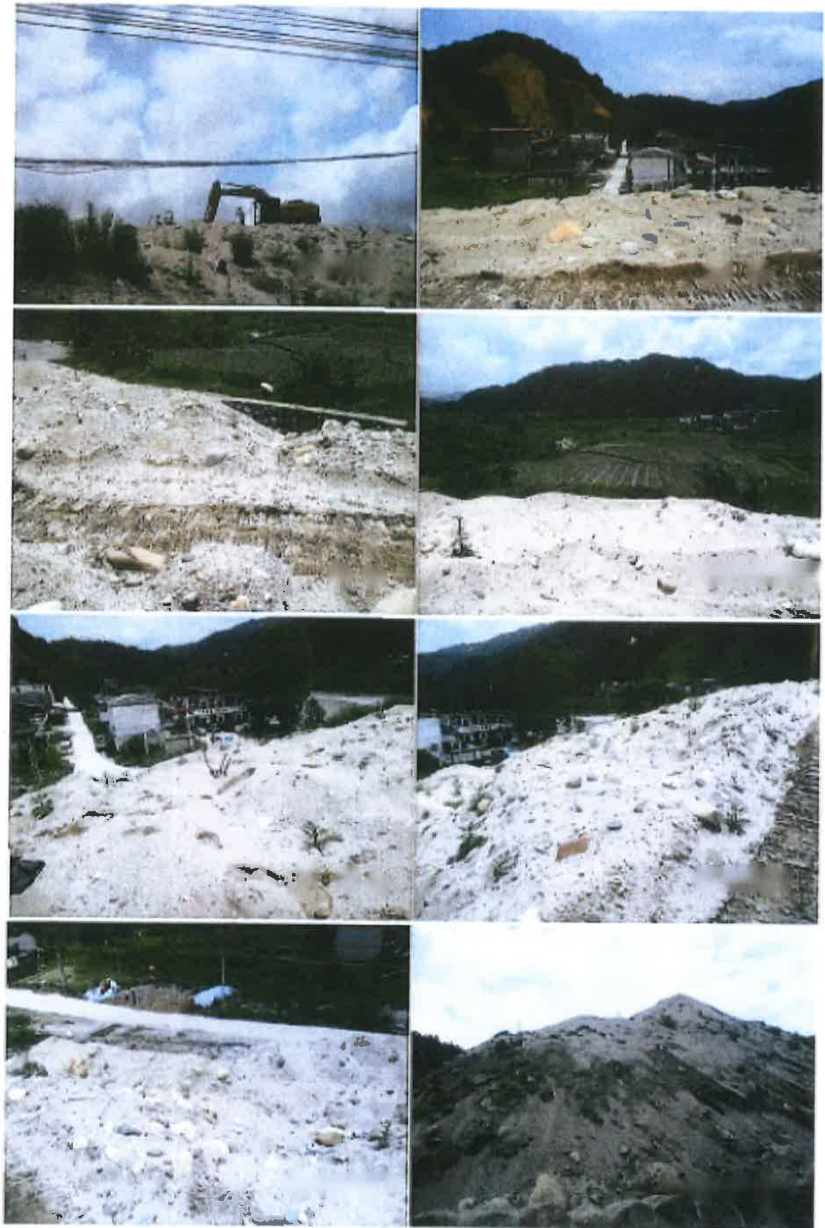
2025 年武江区江湾河道清淤料（梁屋堆场）
