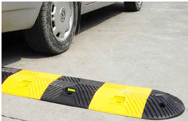
⑤ 高强成品橡胶减速带完成示例图片
