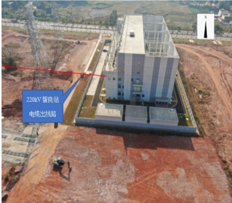
图2.1 220kV智良站出线电缆通道图
