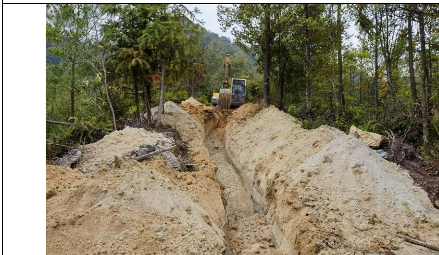
照片 23 TC5 探槽施工
