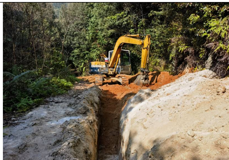
照片 22 TC4 探槽施工（地质界线）
