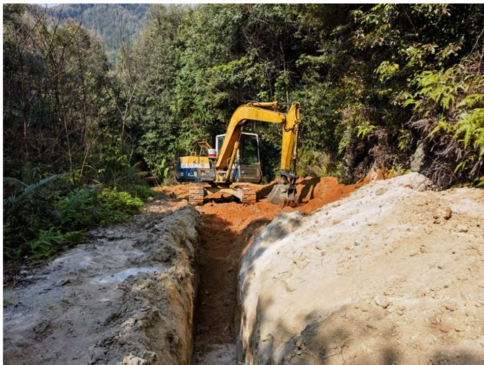
照片 7-1 施工探槽揭露地质界线
